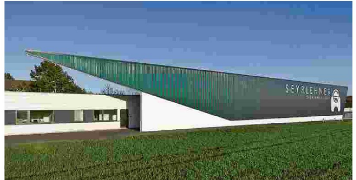
PEM Buildings errichtete für die Firma Seyrlehner in Enns eine Lagerhalle mit einem Flugdach als architektonisches Highlight.
